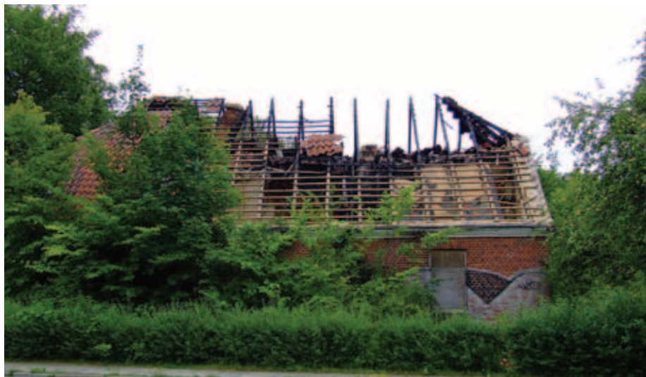
Boligforeningens hus ved Edwin Rahrsvej/ Gudrunsvvej har længe været klar til nedrivning. Nu er der ikke meget tilbage.
