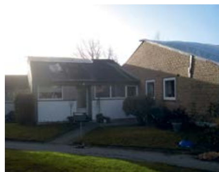
2 huse op ad hinanden fik skader
