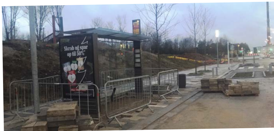
De allersidste dage i november blev der arbejdet på at sætte busstop op på hver side af Karen Blixens Boulevard – ud for Verdenspladsen.
