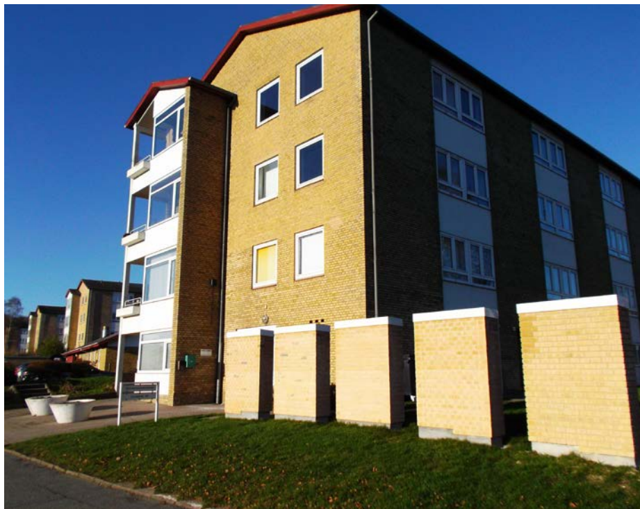
På hjørnet af Louisevej og Anettevej er opført fem mure med forskellige murstenstyper og fugninger.
