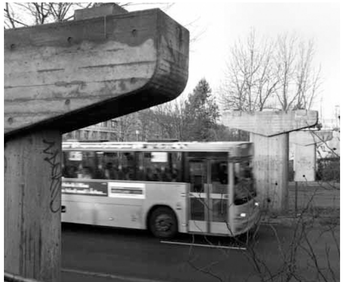
Vangerne, der bærer selve broen, er til reparation i Randers. Foto af Hans Grundsøe
