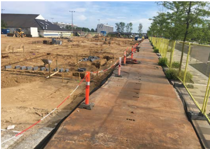
Fundamentet er støbt, og byggeriet af beboerhuset er snart på vej op af jorden.
