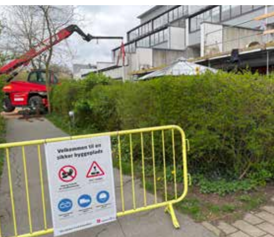
Altanreparationerne er i fuld gang og kører over al forventning. Foto Ulrik D-H.
